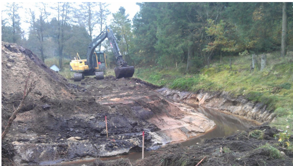
Fra rørlagt til åbent vandløb, Bæksgård Bæk, Vejle Kommune. Foto: Finn Thoft Jensen.
