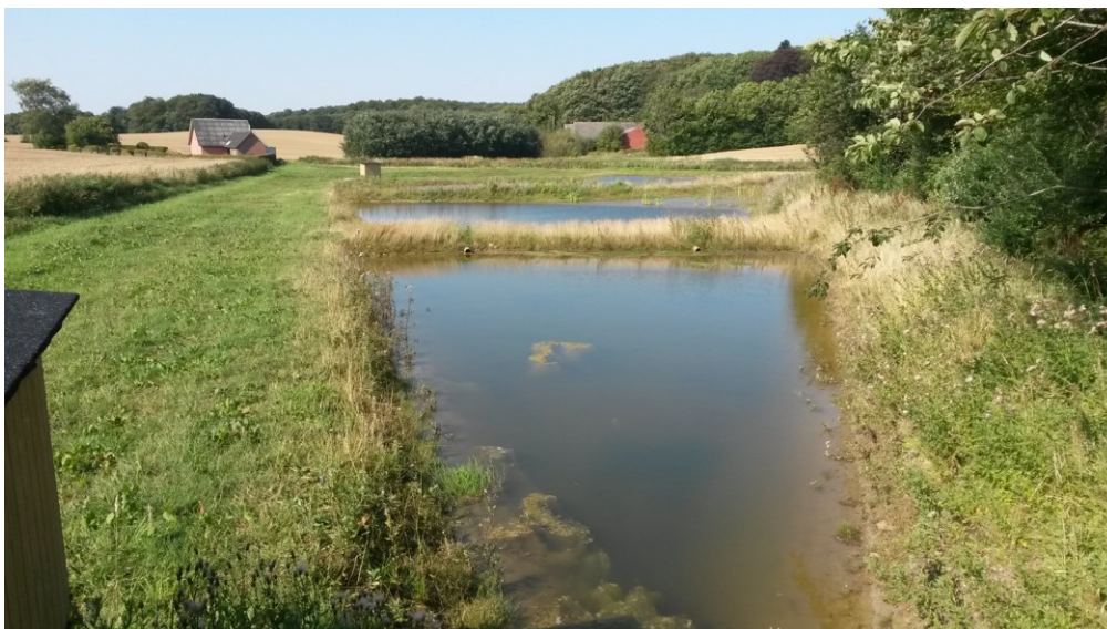
Minivådområde med åbne bassiner i oplandet til Norsminde Fjord. Foto: Susanne Brusvang Hjuler.
