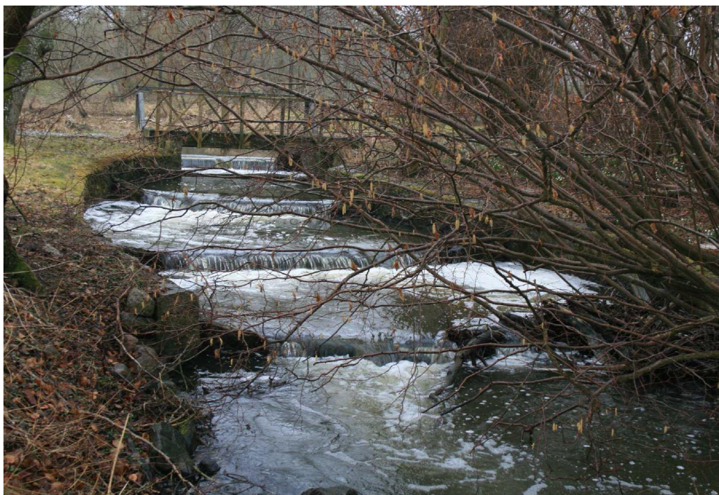
Figur 8: Nuværende fisketrappe, hvori det nye stenstryg opbygges.
