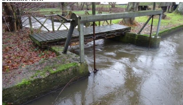
Figur 4: Regulerbart stemmeværk, spang forrest i figuren og fisketrappen i baggrunden.
