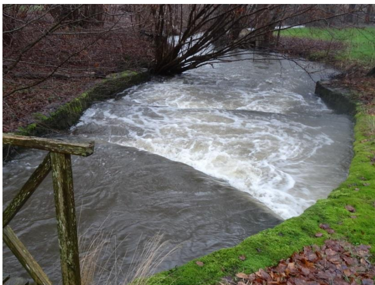
Figur 7: Nuværende fisketrappe, hvori det nye stenstryg opbygges.
