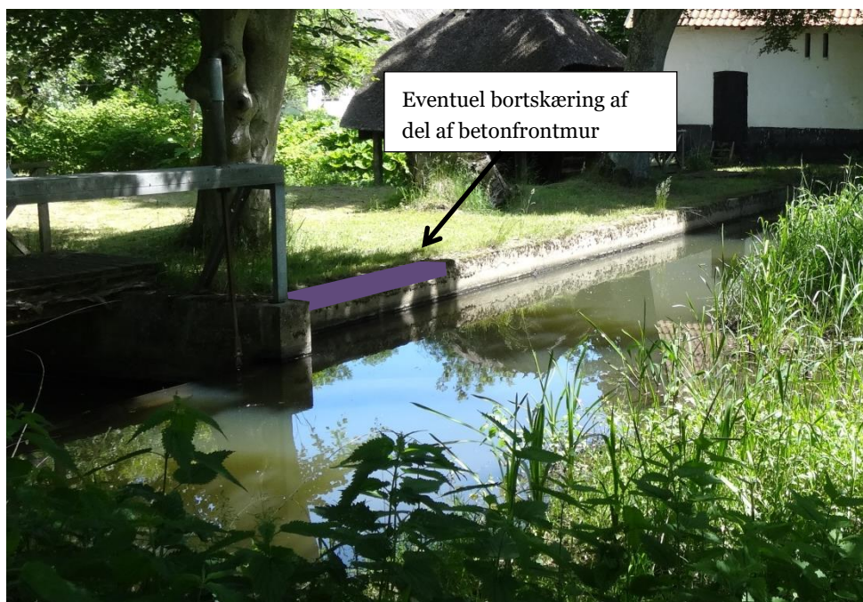
Figur 11: eventuel bortskæring af del af betonfrontmur i den nordlige del af mølesøen ved det nuværende stemmeværk.
